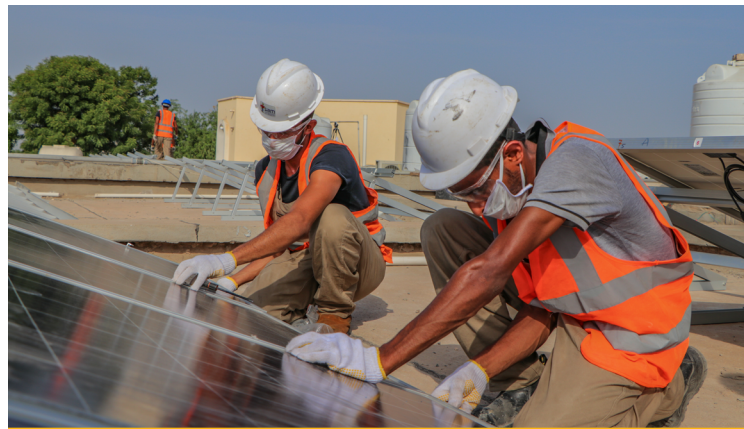
Auf dem Dach eines öffentlichen Krankenhauses in Jemen installieren Arbeiter Solarzellen, damit der durch den Konflikt gestörte Betrieb wieder anlaufen kann.
